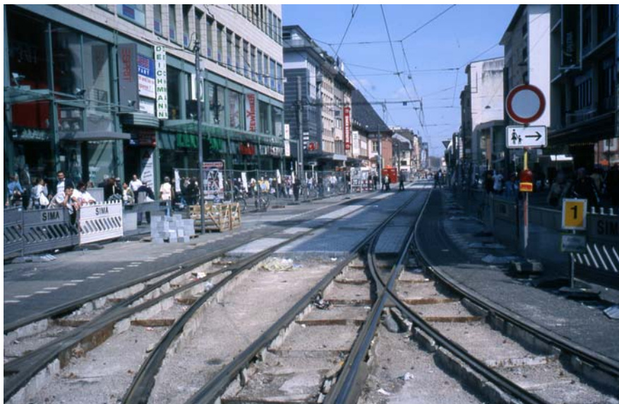
Breite Straße/Kurpfalzachse während der Umbauarbeiten 2006
